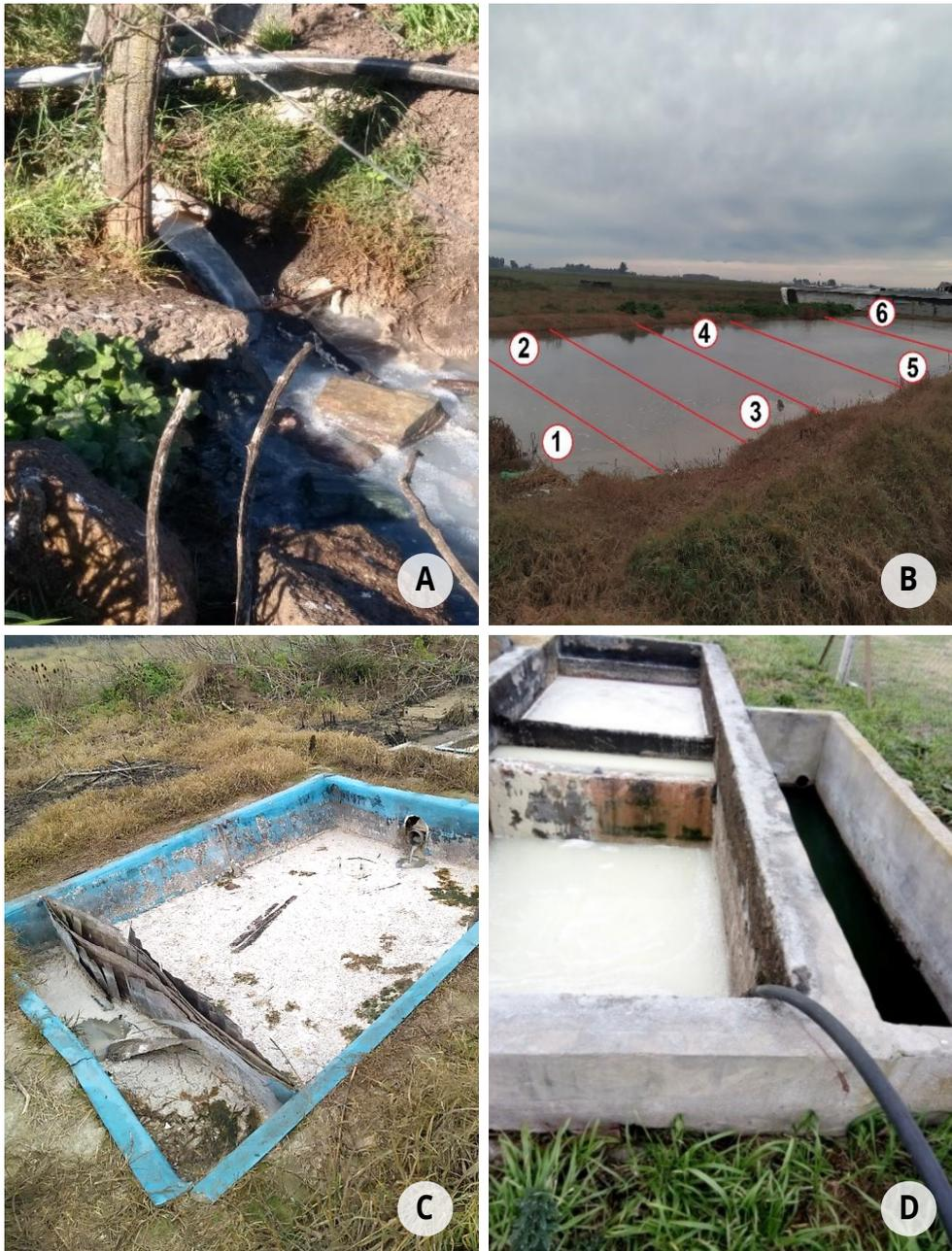
**Figura 1.** Puntos de tomas de muestra. **A)** Vuelco crudo a la salida de quesería en sitio D. **B):** Laguna de tratamiento en sitio E, dividida en cuadrantes para la toma de sub-muestras. **C):** Vuelco a piletas en sitio F. **D):** Sistema de piletas en sitio G.
